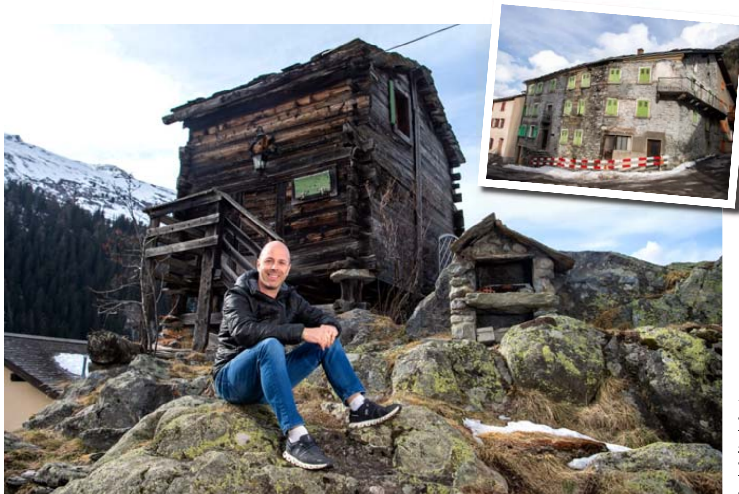
A l'origine du projet Râkâ, Philippe Balleys pose devant l'un des raccards destinés à retrouver une seconde vie. De son côté, l'ancien hôtel du Déjeuner de Napoléon Ier (en médaillon), qui sera réhabilité, jouera un rôle central.
